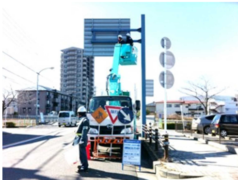
図 2-3-3 道路標識 点検状況
