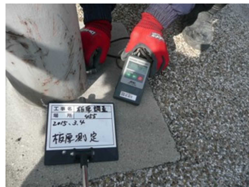
図 2-3-2 道路照明 板厚測定
