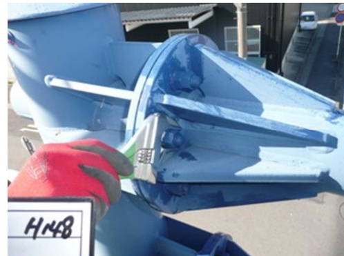
図 2-3-4 道路標識 点検状況
