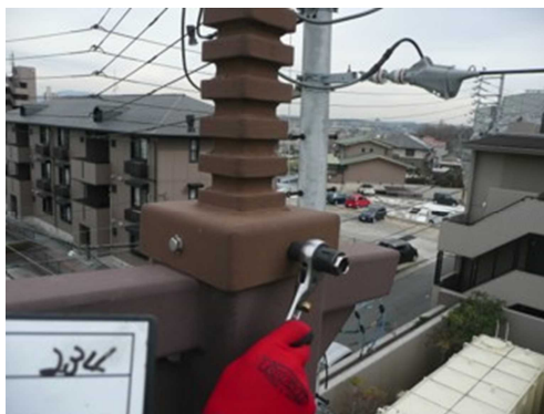
図 2-3-1 道路照明 点検状況
