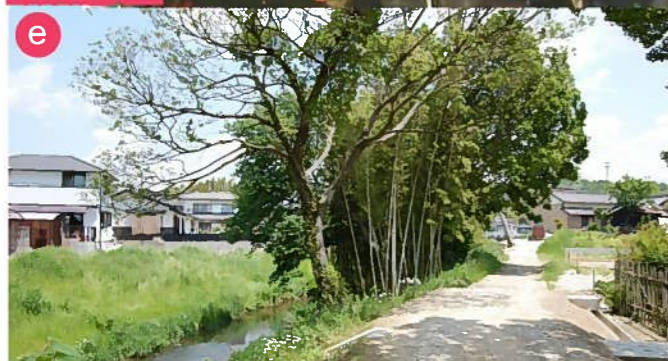
香流川整備基本構想 (H24)時は鬱蒼としていた竹林が間伐され管理道路 (土系) が整備されている
