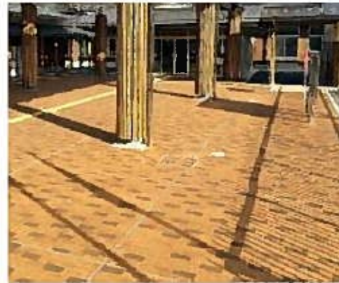
緑道の舗装 木質舗装材ブロック 梣の間伐材を利用したリサイクル材、照り返し抑制及び保水機能を持ち気化熱を利用し周辺の気温を下げる。また木の弾力が歩行時の足腰への負担を軽減する
