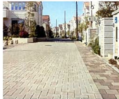
道路の舗装 保水舗装 陶器瓦屑や高炉水砕スラグ等を利用したリサイクル材、照り返し抑制及び保水機能を持ち気化熱を利用し周辺の気温を下げる
