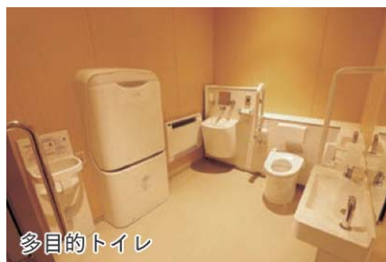
図 多目的トイレ（長野県中野市）
