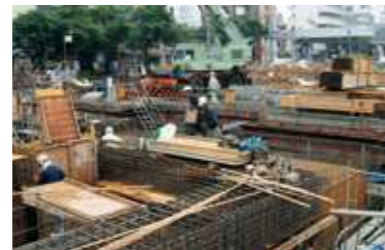
リニモ藤が丘駅の工事
