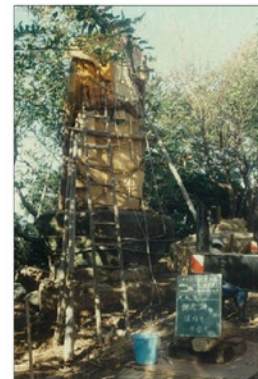
台石と石碑にアンカー設置後据え直
