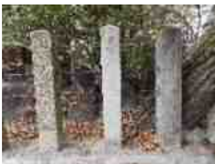
〔西面のコンクリートによる作り変え状況〕
