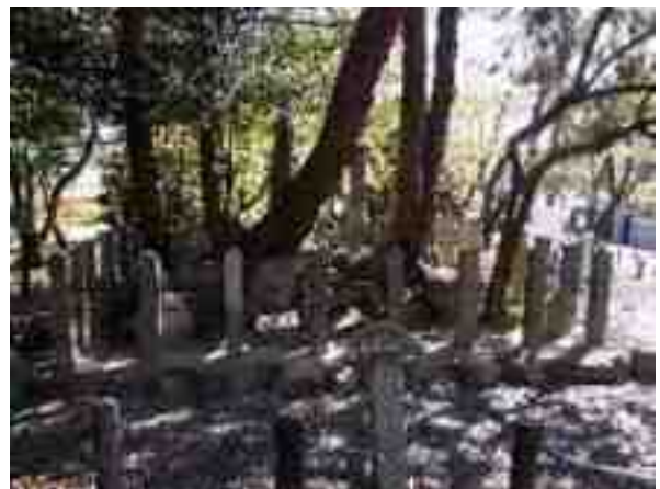
〔背面〕（花崗岩製、内1本コンクリート補修、1本コーキングによる補修痕あり）
