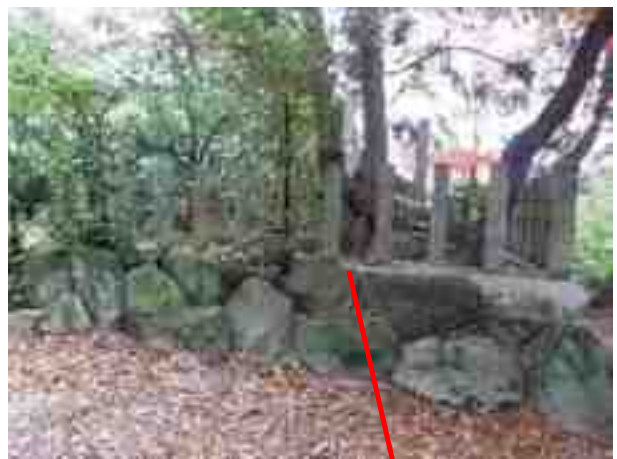
〔左側〕(全て花崗岩製、補修痕なし、 左から5本目文字刻込有)
