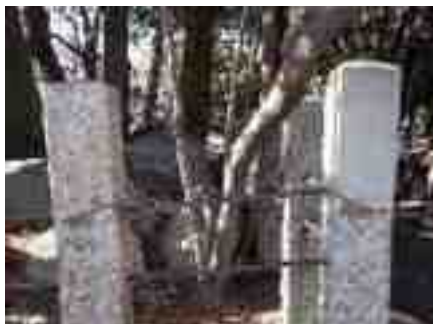
〔コンクリートによる補修〕
