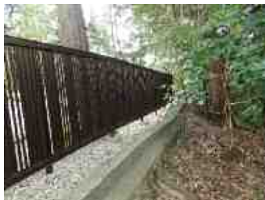
〔転落防止柵、縁石、コンクリートウォール〕
