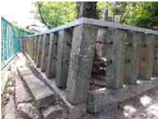
〔北西角〕（石柵はほとんどが傾いており、石積笠石のズレも見られる） ・ 左下にある石材は笠石と使われていたもので、保存してある。
