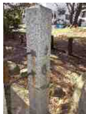
〔背面〕 (花崗岩製、内 1 本コンクリート補修、 1 本コーキングによる補修痕あり)
