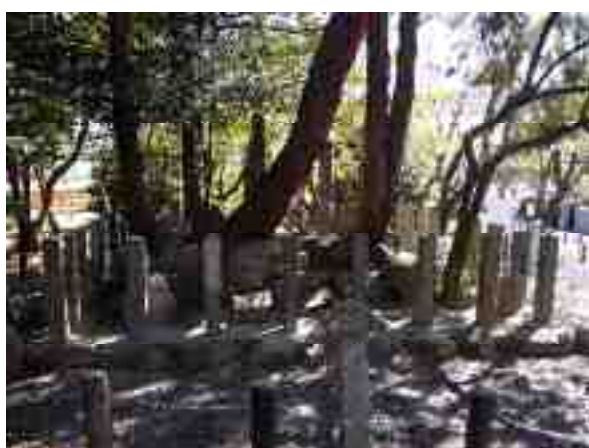
〔背面〕 (花崗岩製、内 1 本コンクリート補修、 1 本コーキングによる補修痕あり)
