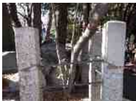
〔コンクリートによる補修〕
