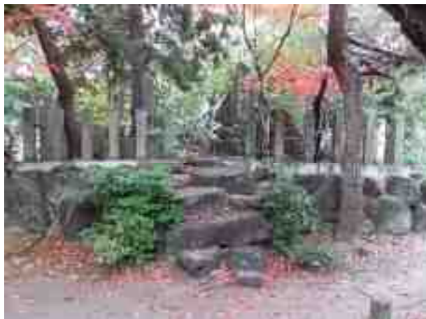
〔正面〕 (全て花崗岩製、補修痕なし)
