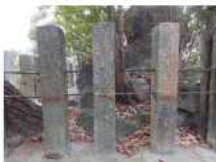
【背面のコーキングによる修復状況】
