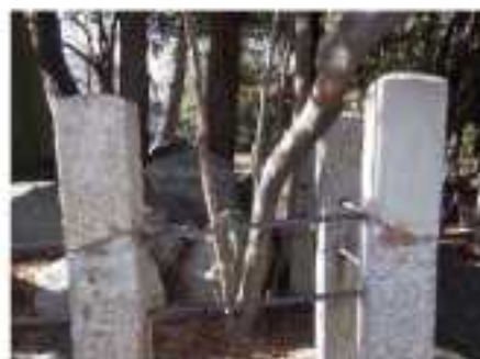
【コンクリートによる補修】
