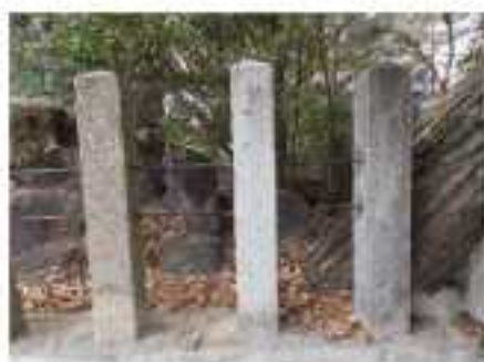
【西面のコンクリートによる作り変え状況】
