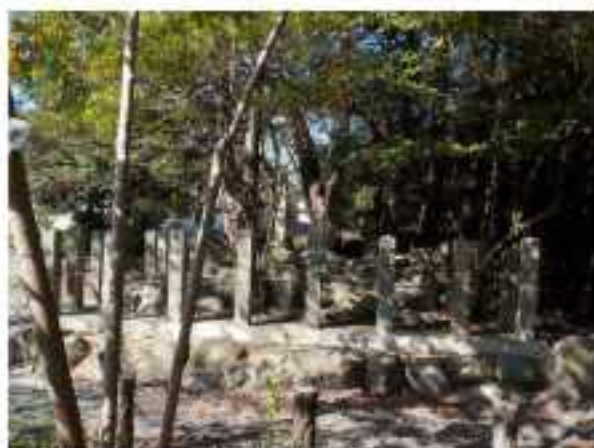
【右側】(8本花崗岩製、内2本コンクリート補修、 4本コーキングによる補修痕あり)
