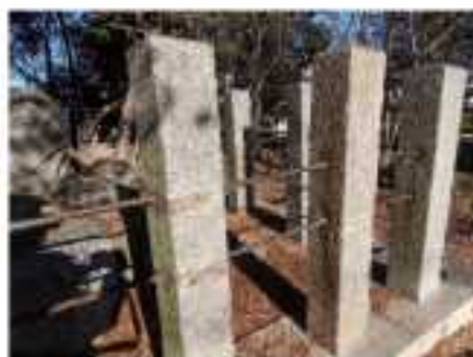
【コーキングによる補修】
