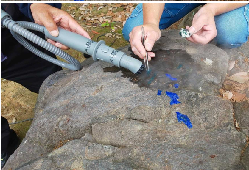
作業状況 高温スチームク リーナーで付着 物を温めピンセ ットで剥離中
