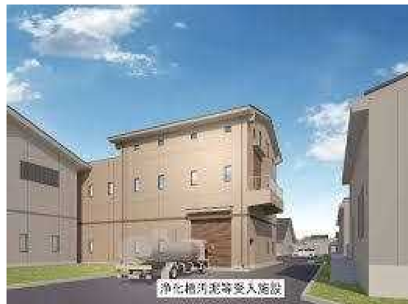
日進市南部浄化センター
