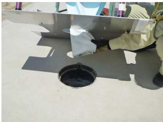
マンホールトイレ設置中（北中）
