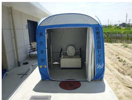
マンホールトイレ設置完了（北中）
