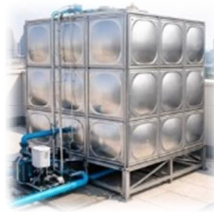
建物に設置されている貯水槽（イメージ）
