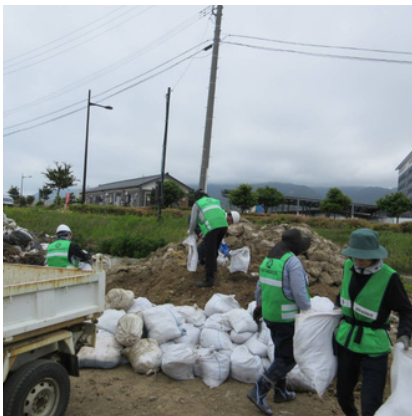
土砂の廃棄作業
