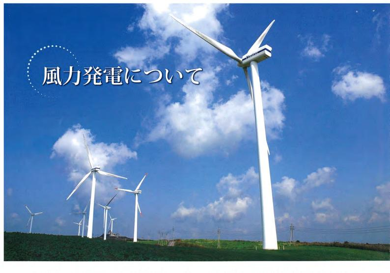
風力発電は、風の運動エネルギーで風車を回し、その動力を発電機に伝達して電気を発生させるシステムです。 風車の形状は風力エネルギーの利用効率が高いことから、発電にはプロペラ型のものが多く使われています。 風力の長所は、再生可能でクリーン、そして純国産のエネルギーということです。短所は風まかせであるため エネルギー密度が低く、電力の出力調整が困難なこと、また化石燃料と比べてコスト競争力に欠けることです。 しかし、こうした風力発電の短所を克服して、風という地球に与えられたエネルギーを最大限活用していくことが私たちに求められています。
