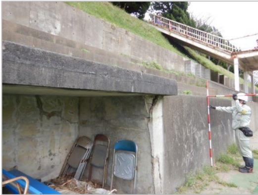
構造物の計測
