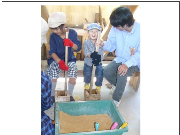
土を木枠に入れて、突き固めます。 なかなか根気が必要です！
