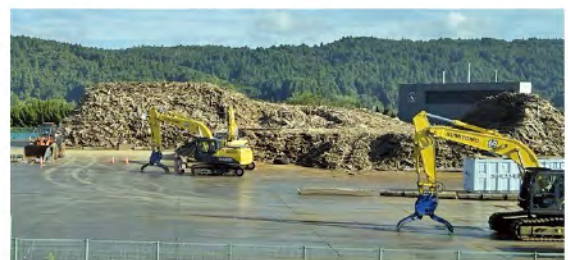
がれきが積み上がった野球場
