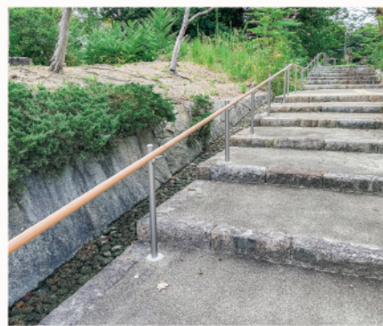
手すりも設置されていました
