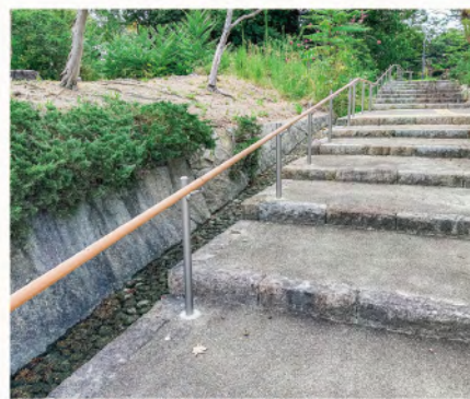
手すりも設置されていました
