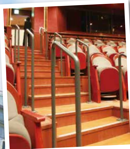
手すりの設置 (森のホール)
